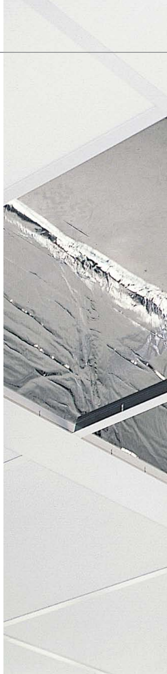
Figur 3: Klargjort for montering av skillevegg med Rockfon Soundstop
